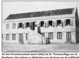
De Sint Vincentius school stond vlakbij het St. Thomaspollage aan de Roofweg. Het gebouw is afgebroken voor de bouw van de polikliniek van het St. Elisabeth Hospital.
