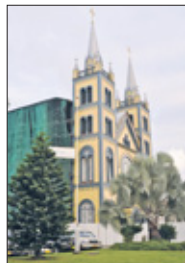
De historische houten St. Petrus en Paulus kathedraal, die momenteel wordt gerenoveerd.
