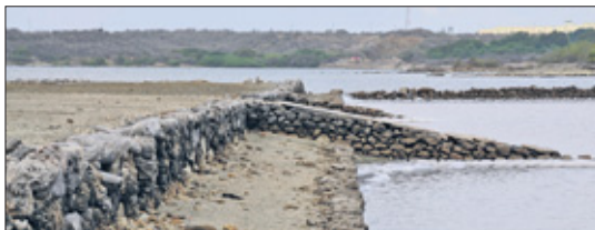
Herinnering aan de muurtjes, die eigenaar Casper Perret Gentil van Jan Thiel had laten aanleggen.
