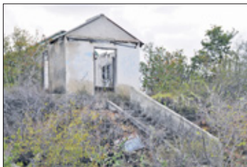
Resten van een gebouwje bovenop een heuvel, van waaruit de opzichter de werklui in de gaten hield.
